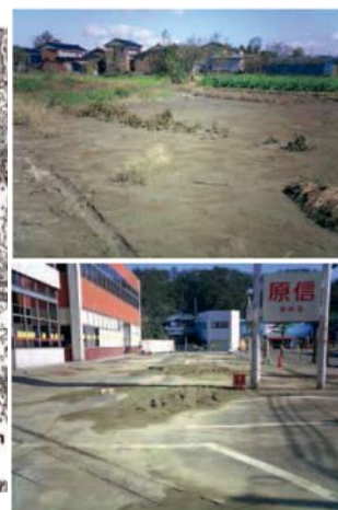
図-6 新潟中越沖地震における液状化事例（見附市刈谷田川）
